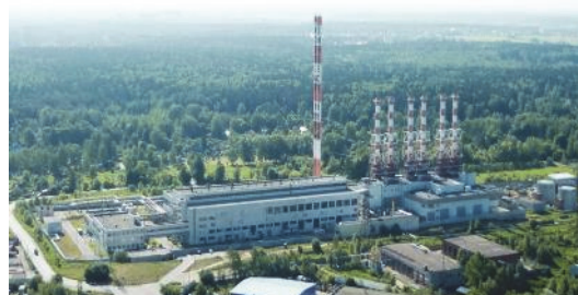
Районные тепловые станции Зеленограда
